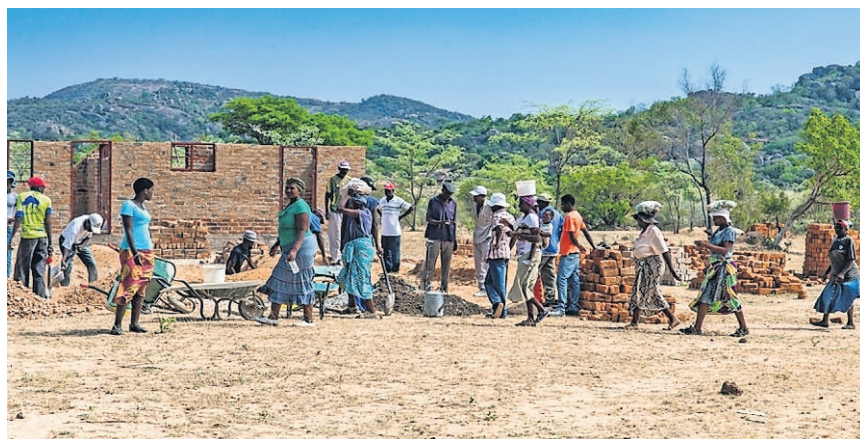
Bau einer Klinik in Matabo-Kezi.
