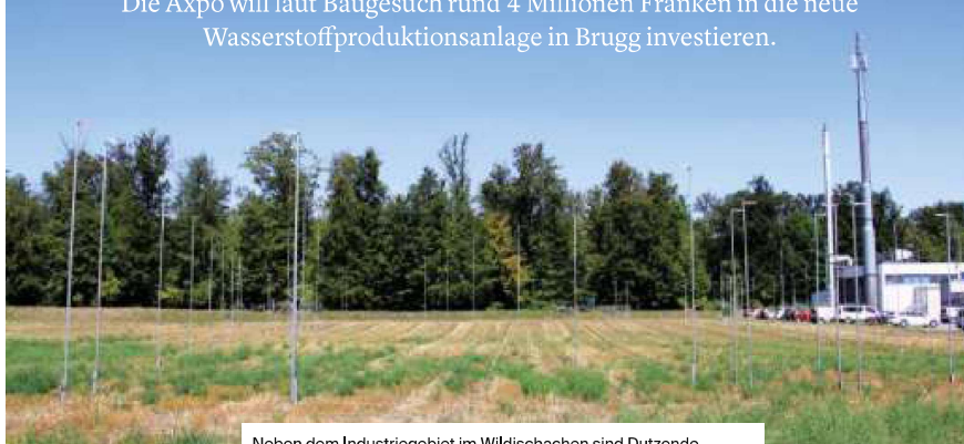
Neben dem Industriegebiet in Wildischachen sind Dutzende Bauprofile für die Wasserstoffproduktionsanlage zu sehen. Bild: cm
